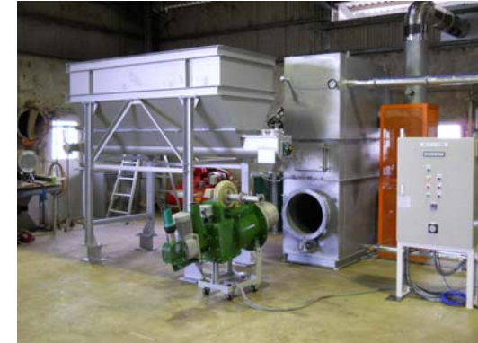
【鶏糞専焼 温水缶設備】 Joule-R10 100,000kcal/h
